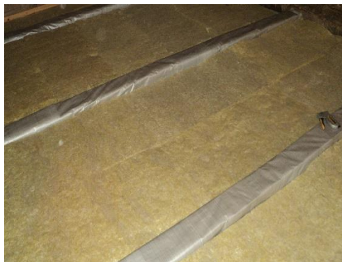
Утепление чердачного перекрытия плитным утеплителем
