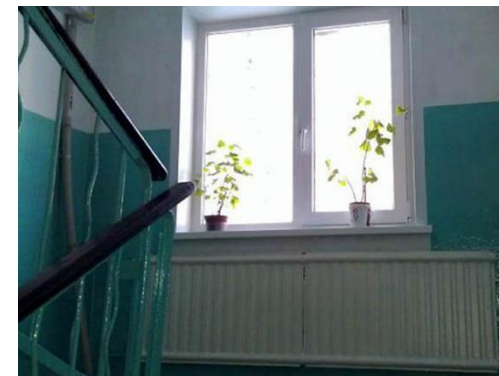
Замена старых окон на энергоэффективные
