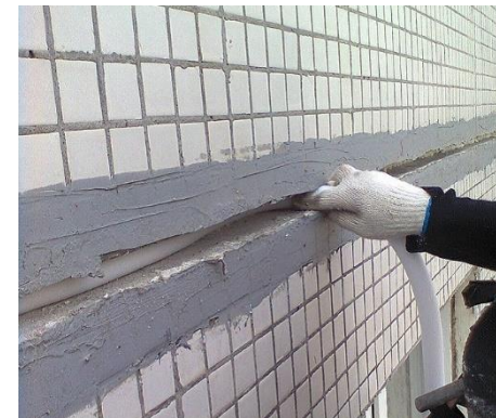
Заделка межпанельных швов
