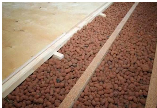
Утепление рыхлыми засыпками
